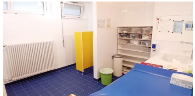
Auch das Bad in der Kita am Park Haus A wurde neu gestaltet.
