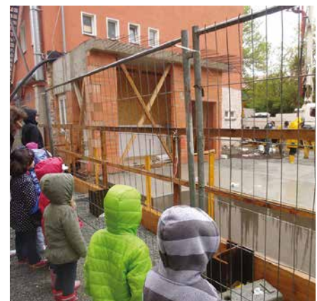
Baustelle im Kinderzentrum Lindenhof
