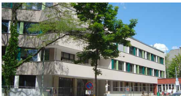
Das Nachbarschafts Haus Friedenau im Juni 2010 nach Beendigung der Sanierungsarbeiten
